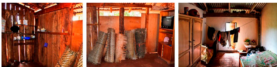
ADAPTACIÓN DE LOS ESPACIOS. UTILIZACIÓN DE LA ESTRUCTURA PARA ALMACENAR Y COLGAR
