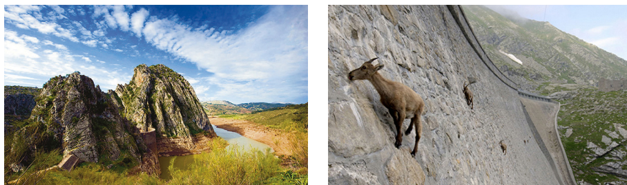
Figura 2. Izquierda: Presa de Montjaque, río Guadare, España. Fuente: A. Sánchez. Derecha: Ibices en la presa Cingino, Italia. 1930. Fuente: www.flickr.com .
