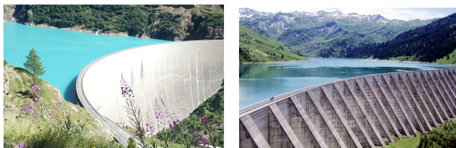
Figura 3. Izquierda. Presa bóveda de Place Moulin, Vallpelline, Italia. 1965. Fuente: www.wikimedia.org . Derecha: Presa de Roselend, lago Roselend, Francia. 1962. Presa aligerada. Fuente: www.astronoo.com .
