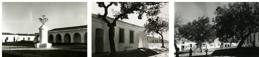
Figura 6. Plaza alta y viviendas Minas de las Herrerías (a, b y c). Fotografías de A. Herrero, 1962. Fuente: AMH,FAH. leg-60.
