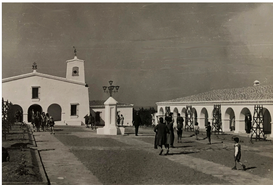
Figura 4. Plaza alta y capilla en la Aldea de Minas de las Herrerías, Puebla de Guzmán. Fotografía de A. Herrero 1962. Fuente: AMH_FAH
